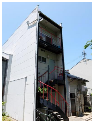
東立面 リノベーション着手前
