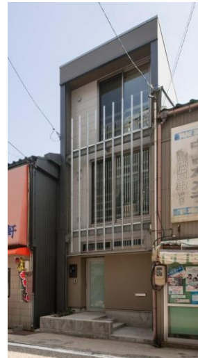
西立面 リノベーション後
