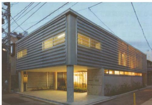
この建物は一般事務所兼住宅で、立地する街形態は、小規模ビルと住宅とが混在する都市環境にある。隣接する既存住宅に対して採光、通風、プライバシーに損失を与えないように階高を下げたり、窓が相互に対面しないようにずらしたりして、自らの家を既成の周辺環境にしたがいながら馴染ませる手段が採られている。居住空間は2階にあるため、光の透過性の高い有孔折板で被ったバルコニーを設けて、室内側からの開放感を、そして外部からのプライバシーを巧みに確保している。都心の住宅にあって、安心かつ快適に住むという課題に真摯に取り組んでいる姿勢は好感をもって受け入れら、都心居住の在り方に一石を投じた作品であることも高く評価された。
