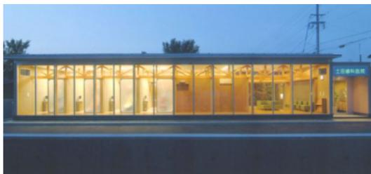
患者と診療スタッフの動線空間である通路をそれぞれ分けたことが独創的で、それがしっかり機能している点が高く評価された。また診察室は隣同士が隔壁で閉ざされているが、患者が出入りする箇所は、半透明の可動パーティションを付けて半個室化することによって患者のプライバシーが保たれ、患者本位の空間となっている点も評価された。建物の正面は床から軒先まで一枚ガラスで造りあげ、それを水平方向に連続されることで、全面が一枚のガラスで構成されているようにみせ、インパクトのある外観を創り出すことに成功している作品である。
