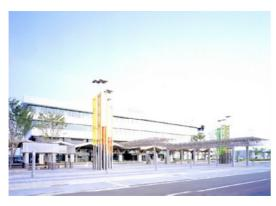
小規模な空港ターミナルビルで空港機能は一、 二階のみであるが、四階建てとして上層に農林事 務所など行政機関を入れて、空港機能の将来成長 に伴う拡張に対応した計画になっている。またこ のことで小規模ターミナルビルにも拘わらず、三 階高のある大きな吹き抜け空間を出発ロビーに与 えることを可能にした。一階ロビーや見学者デッ キから出発ロビー空間を抜ける自然通風換気や雨 水の中水利用、水蓄熱冷房システムなど環境負荷 の軽減に努めた設計を行っている。
