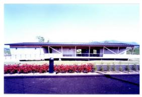
管理室、倉庫、便所から成る棟の二棟を、バリアフリーをテーマとして設計している。バリアフリーは通路の問題であり、管理棟は独立させた各室を面的に配置し回廊形式で繋ぎその上を大屋根で覆ったデザインで、外観は直方体が雁行したかっちりした構成である。一方の便所兼倉庫棟は各室を一列に並べ直線的通路で繋いだデザインで、床下ピットを設けて高床式とし軽快な構成で纏めた。小公共建築に対する提案性が評価された。
