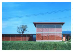
柱、梁、桁、本実にした壁板、筋違などの構造材をそのまま仕上材ともしている。外壁と塗装の経年変化を避け、壁結露を排出するために外壁全面にガラスを張っている。また、機械空調を避け蓄熱床暖房、雨水利用と散水による蒸発熱屋根面冷却など自然力利用の室内気候調節を試みている。建具その他の収まり設計、吹き抜け空間に配置したDKの調理時の煙や臭いを室内に拡散させないためのドラフト・レンジ・フード設計など、様々な実験的提案が評価された。
