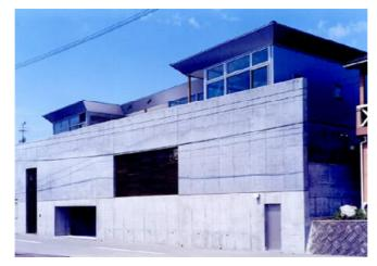
前面に高く長い鉄筋コンクリート打放の壁を置き、その内側に地階の玄関、 一階の応接、録音スタディオ、書斎た の閉鎖的空間を置き、この壁をが、河野で 上部に二階を置いて、リビング、河水らの眺望に可称を置いたコントがらのシーで の眺望に開放的に配置したコントが成功している。この壁は外では外でに対したのはは外では対している。は外ではいてはいてはいいではがいたがでいたがで、乱れてをとまった。「壁」のコンセプトが明快である。
