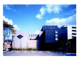
一階が銭湯、二階に住宅を載せる併用住宅で、 閉鎖的にせざるを得ない銭湯の浴室部と脱衣化粧 室の間に中庭を配して開放感を与えている。住宅 が二階部に置かれやはり閉鎖的になる処を、ルー フガーデンを巡らせてこれと一階の中庭と空間的 に連続させることで自然に開放された住まい空間 を作っている。
